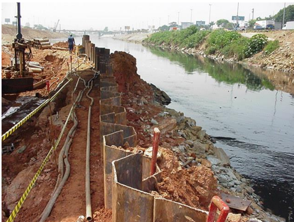
Figura 44 – Estacas U cravadas na margem do Rio Tietê. Fonte: Bernd Fröhlich.
