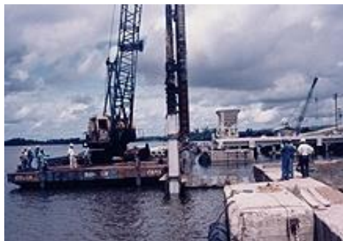
Figura 40: Cravação de estacas prancha de concreto. Fonte: http://civilport.com.br/ (23 de novembro de 2008)
