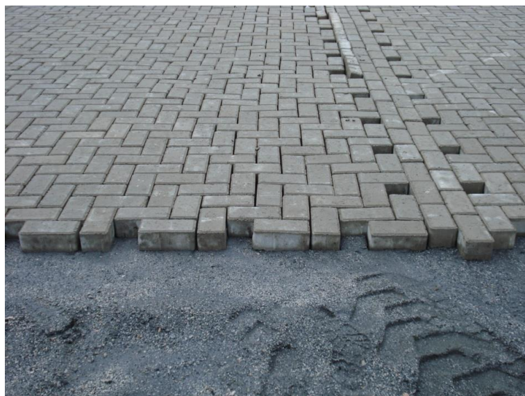
Figura 18: Pavimento de blocos intertravados de concreto sendo executado no TECON IV.
