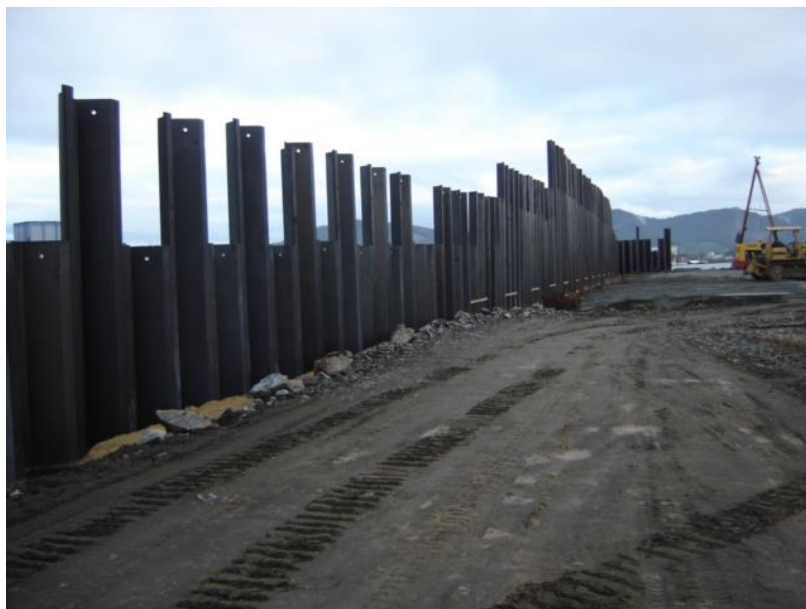
Figura 50 – Paredão de estacas-pranchas cravadas de forma intercalada. Fonte: Bernd Fröhlich.
