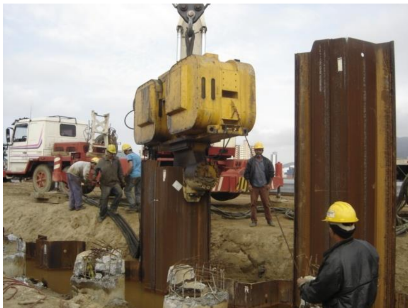
Figura 48 – Vibrador atuando sobre a estaca-prancha metálica. Fonte: Bernd Fröhlich.
